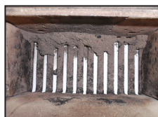
Cestello che necessita di pulizia
